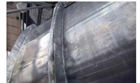
▲ Die vertikalen Längsseiten der Schare auf den Hauben sind durch Hohlwulste verbunden
