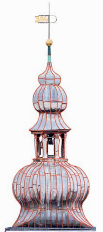
▲ Die genaue Position der einzelnen Schare der Turmhaube wurde exakt dokumentiert
