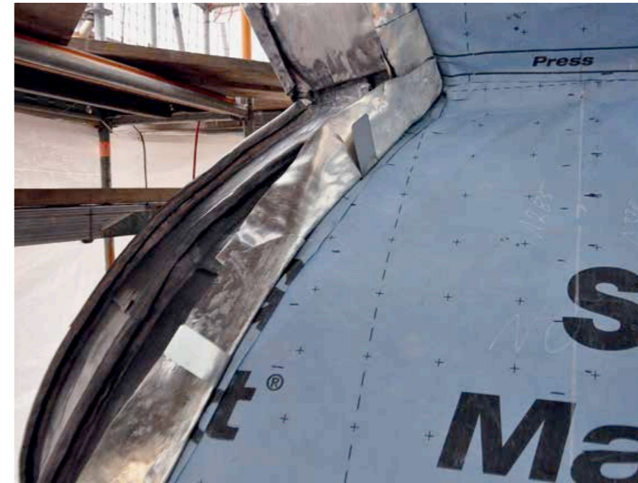
▲ Hier hat Korrosion künftig keine Chance mehr: Zur indirekten Befestigung der unterseitig verzinnten, 2,5 mm dicken Bleischare kommen haltbare Edelstahlhafte und -schrauben zum Einsatz
