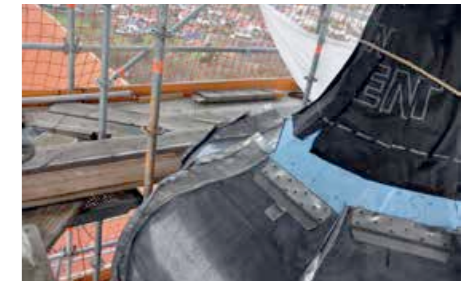
▲ Zur Windsogsicherung werden die Schare mit durchgehenden Nagelreihen befestigt
